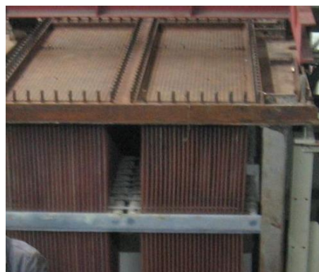
Rys. 5. Poziom najwyższego dystansownika przed zainstalowaniem spryskiwacza, po zainstalowaniu spryskiwacza
