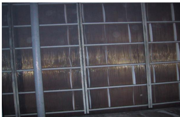
Rys. 3. Przekrój wlotowej sekcji zmontowanej chłodnicy spalin
